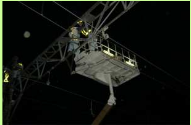
【夜間のトロリー線張替作業】
