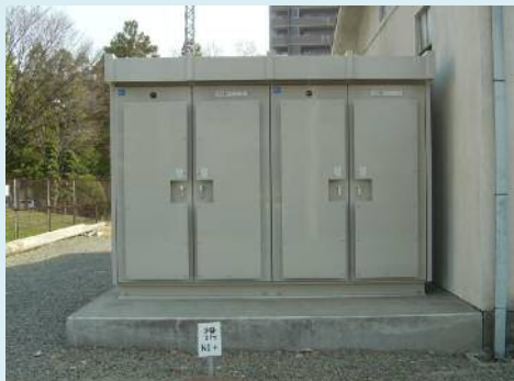
【新設された自励式回生電力吸収装置】
