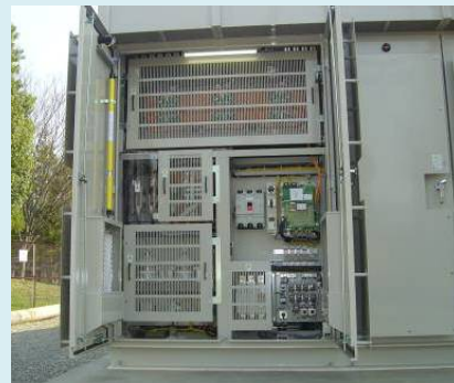
【新設された自励式回生電力吸収装置】
