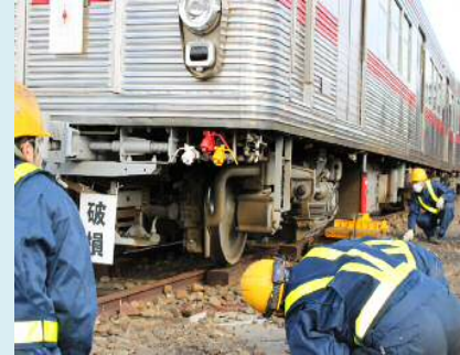
【脱線復旧作業】
