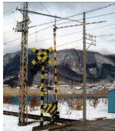
屈折式に改善した遮断桿
