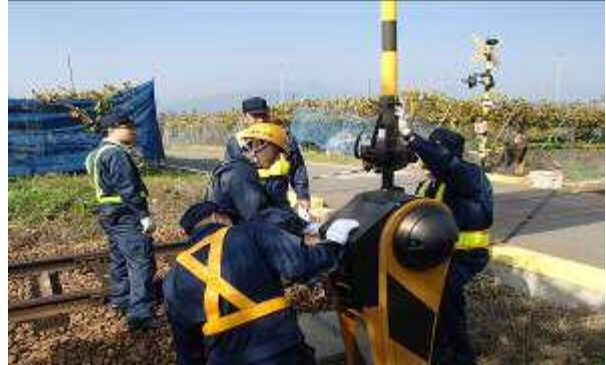
踏切異常時訓練
