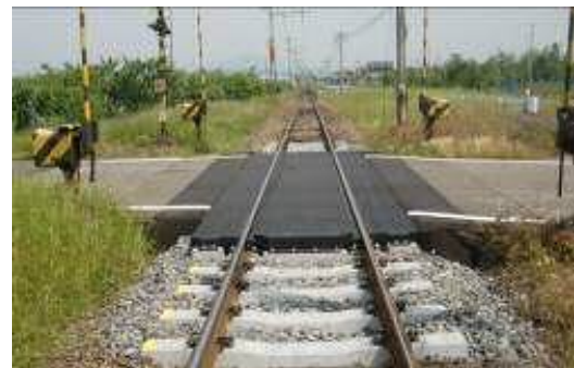
高畑学校道踏切道（須坂駅～北須坂駅間）
