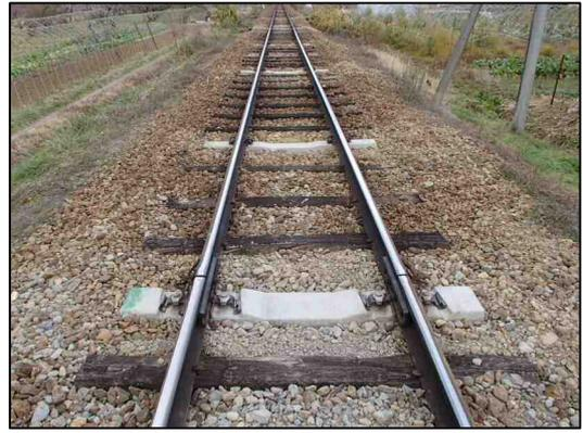
木マクラギのPCマクラギ化
