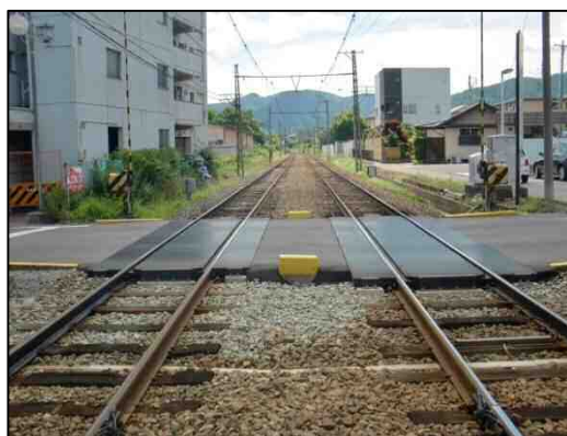
桐原西踏切道（本郷駅～桐原駅間）
