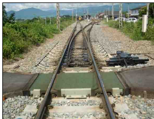
分岐器50kgN化(小布施駅構内)
