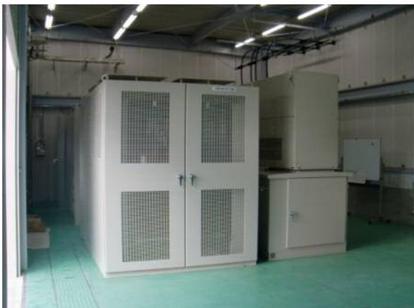
須坂変電所 1000kw整流設備
