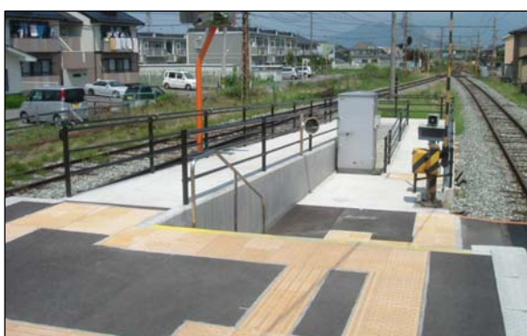
柳原駅スロープ新設
