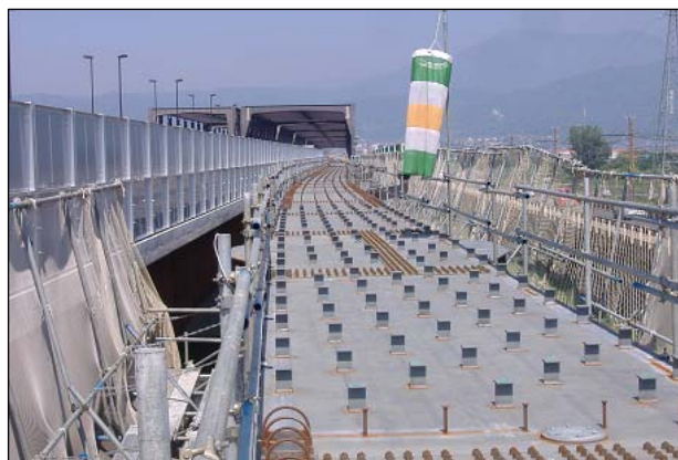
村山橋架替え工事
