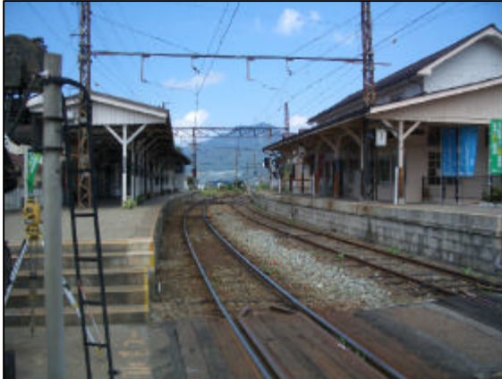
改修前の湯田中駅ホーム
