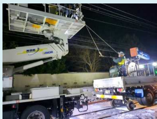
【トオリ線交換作業】
