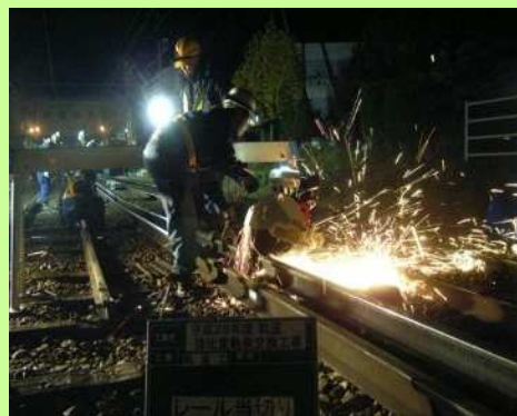
【夜間のレール交換作業】
