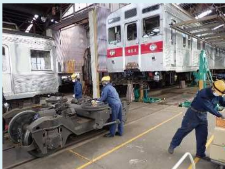
【台車の取り外し作業】
